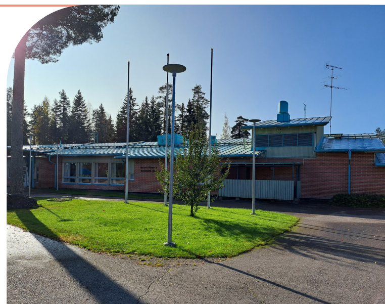
Rautjärven Asemanseudun koulurakennuksessa muokataan uusia toimintaympäristöjä varhaiskasvatuksen tarpeisiin.
